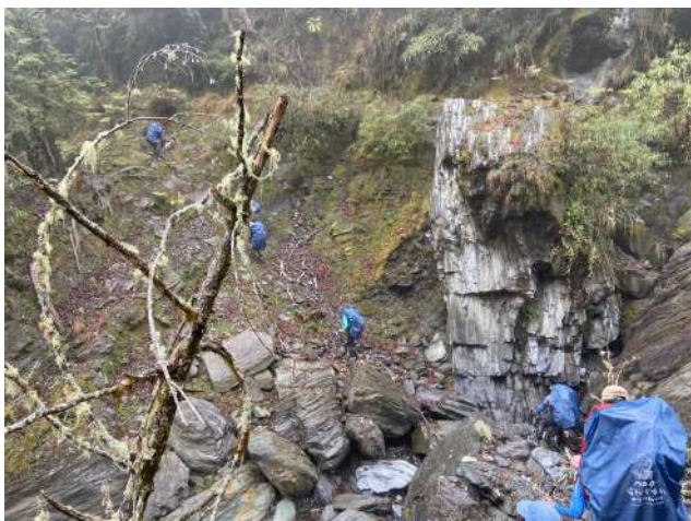
圖 8 林道崩塌下切路徑
